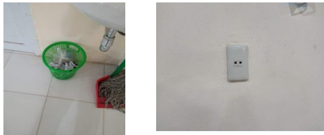
Gambar 4. Kotak kontak dan tempat sampah
